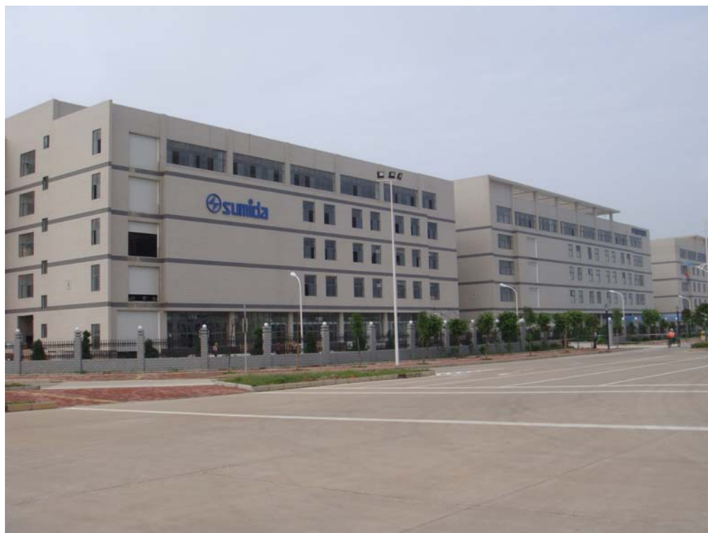
南寧工場の外観
